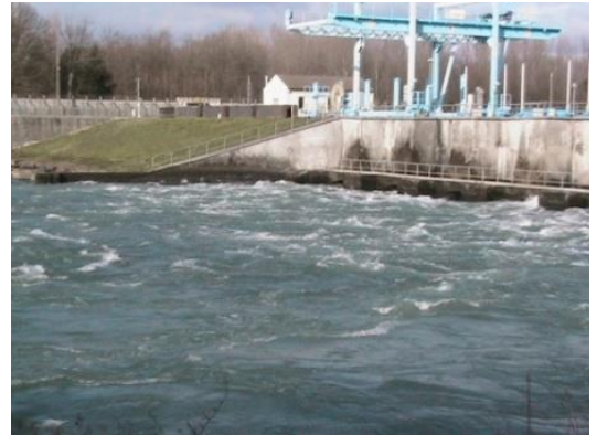
Barrage réservoir de Jonage
